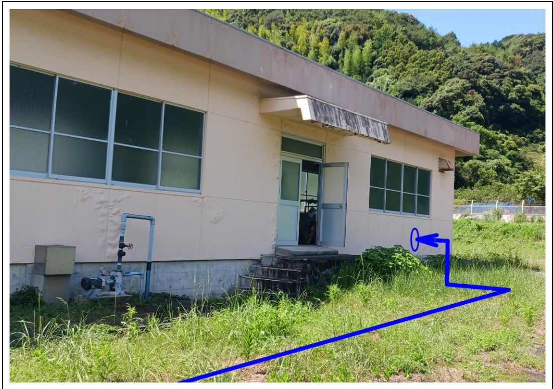
現場写真-3 急速ろ過池操作室 (新設配管、ケーブルルート、壁穿孔あり)
